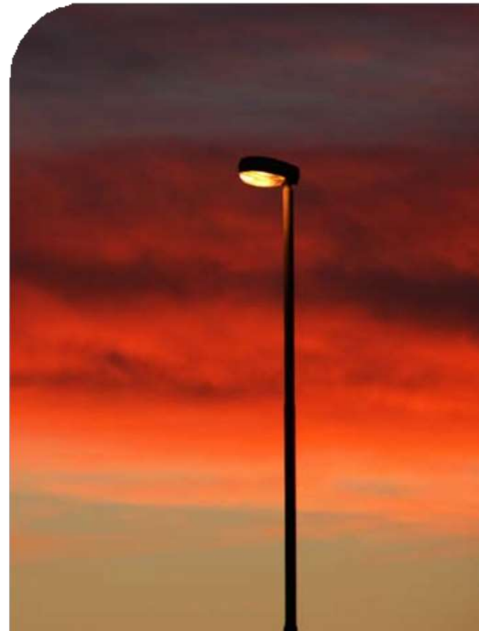
Smart straatverlichting geeft de beheerder de mogelijkheid gehele straten tegelijk te monitoren.
